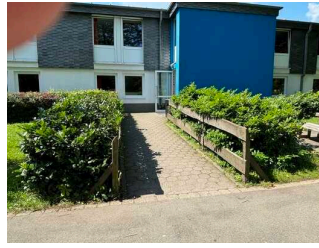
Verbindungswege zu den Häusern im Aussenbereich
